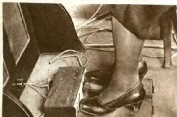
Электромеханическая педаль управления громкостью и вибрацией «ними».
