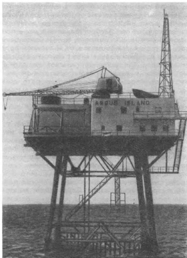
Искусственный гидроакустический остров Аргус — довольно необычное сооружение в открытом море, снабженное оборудованием для исследований по распространению звука в море.
