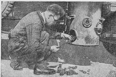
Рис. 1. Заполнение углем нижнего конуса топливника газогенератора
