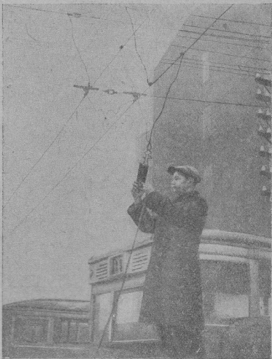
Рис. 3. Включение соединительного шнура в подвеску контактной сети
