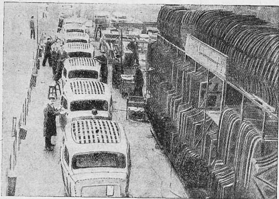
Сборка кузовов на конвейере
