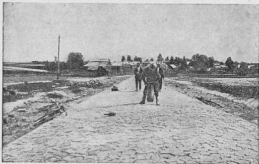
Утрамбовка торцовой мостовой. На снимке — общий вид незаасыпанной дороги участка № 1 тракта Семенов — Горький
