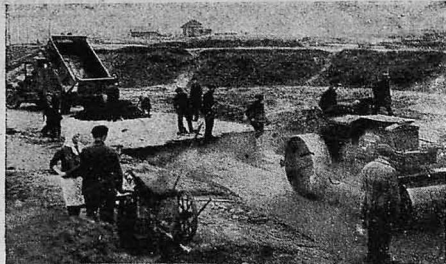
Асфальтирование новой дороги к «Шарино-подшипнику» (Москва)
