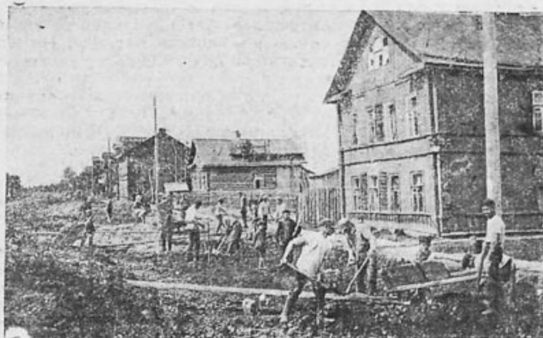
Улучшают дороги в рабочем районе Ленинграда (Обуховская ветка)
