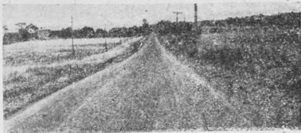
Вид улучшенной гравийной дороги
