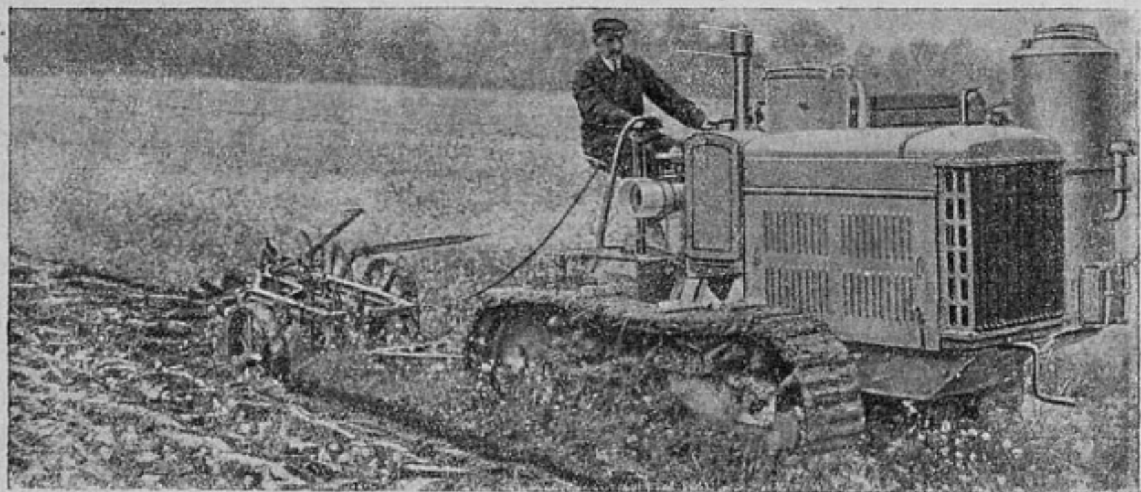
Гусеничный трактор „Рено“ с газогенераторной установкой
