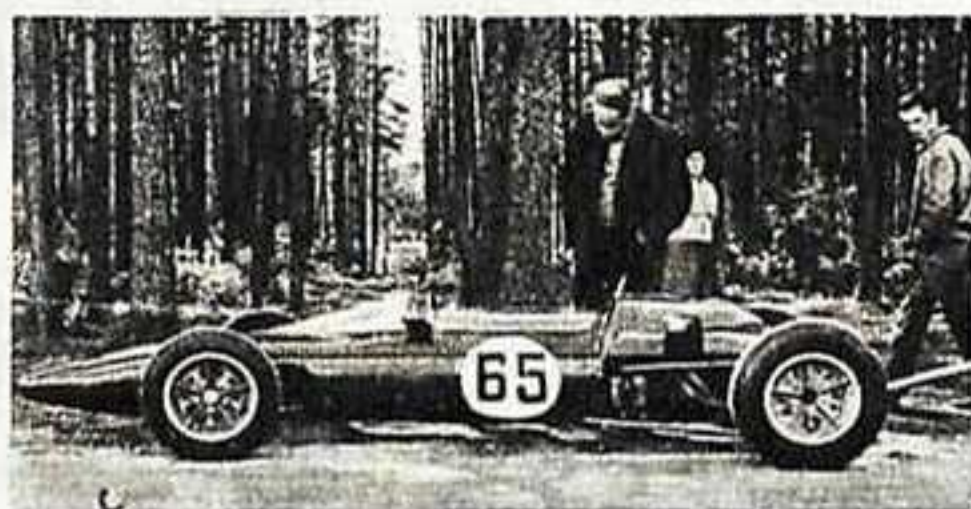
Машина «Эстония-9» Ю. Андреева снабжена двигателем мощностью 95 л. с., магнетиными колесами и тормозными барабанами.
