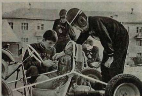
Вверху: кружковцы за сваркой рамы карта. В. Кузнецов (слева) и М. Пучков. Внизу: юные картинисты Дворца пионеров за регулировкой карта.
