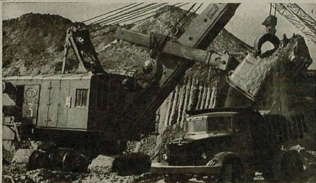
На строительстве Михайловского железорудного комбината. Вскрышные работы в карьере (см. стр. 4).
