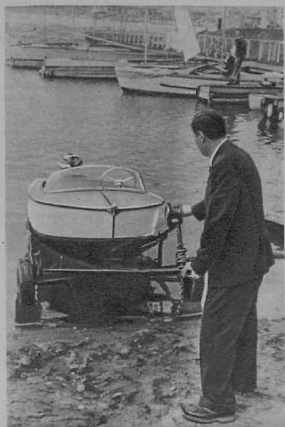
Рис. 6. Спуск катера на воду с прицепа АМ-1.
