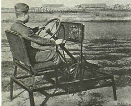
Главное для будущего водителя — отработать координацию движений рук и ног при управлении автомобилем. Это легко сделать на тренажере. Изготовить его нетрудно, а пользу он приносит немалую.
