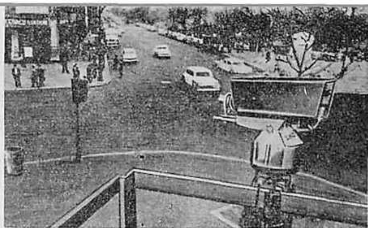
Рис. 2. Телевизионная камера на перекрестке улиц в Нью-Йорке.
