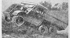
Рис. 2. Тягач фирмы Австро-Даймлер с двойными передними колесами для уменьшения удельного давления на грунт и лучшего зацепления с грунтом
