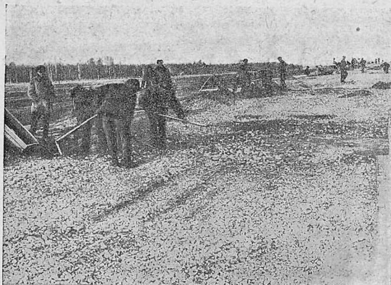
Работы по ремонту Серпуховского шоссе
