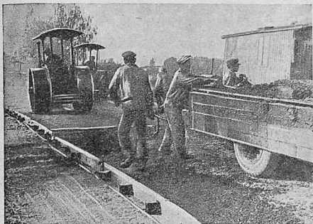
Укладка и укатка массы на строительстве шоссе Энтузиастов (Москва)
