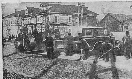
Работы по асфальтированию Рязанского шоссе
