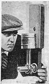
Рис. 3. Проверка прямолинейности шатуна и правильности монтированного на нем поршня
