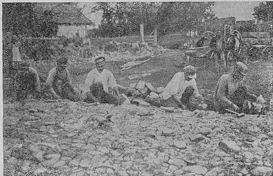
Строительство дороги через дер. Ново-Амирово, Буздякского р-на, Баш-республики, в месте, где раньше было непроходимое болото
