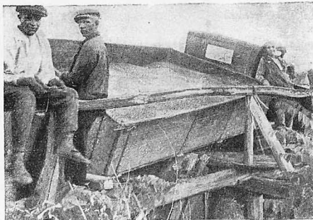
Плохие дороги и мосты срывают хлебослачу. На снимке — автомашина с хлебом по пути из станции Владимирской на элеватор провалилась на гнилом мосту (Лазинский район, Северный Кавказ)
