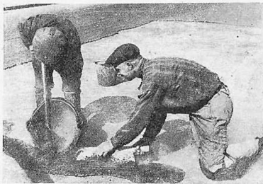
Ремонт асфальтовой мостовой в Москве
