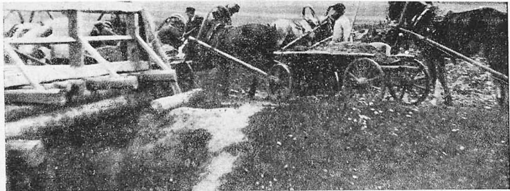
Ремонт моста на сельской дороге с трудучастием населения
