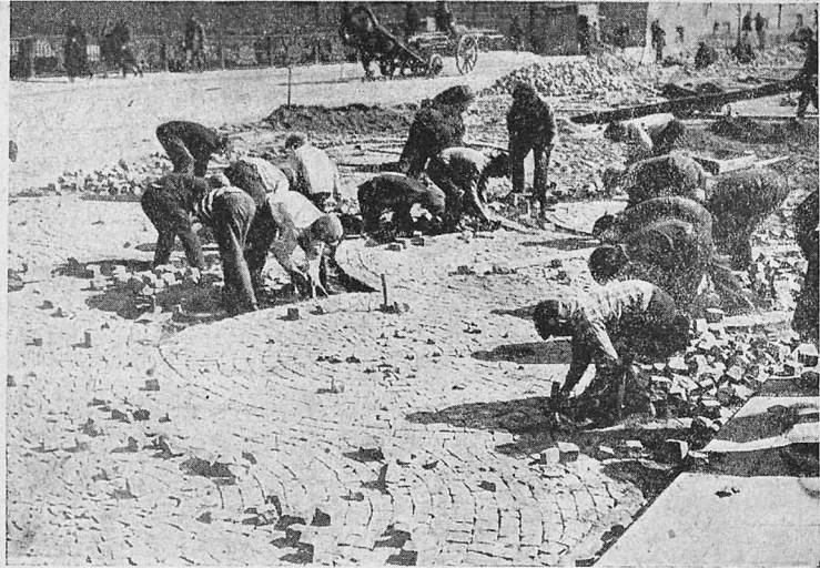
Город Ленина приводит в образцовый порядок свои мостовые. Выстилка узорной диабазовой мостовой на мосту Пестеля (май, 1932 г.) Союзфот
