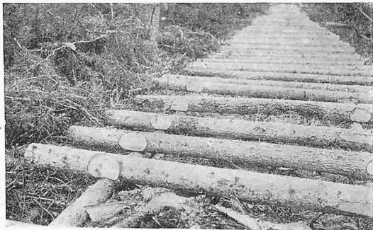
Основание из круглых шпал для лежневой автомобильной дороги в Карелии
