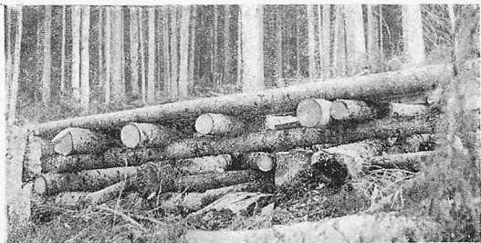
Клетка из бревен под лежневую дорогу для перехода впадины в грунте
