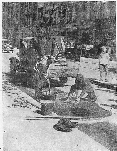
В дорожных работах в Москве применялся усовершенствованный способ доставки расплавленной асфальтовой массы к местам работ. Масса доставлялась на грузовиках в котлах, специально подогреваемых в пути
