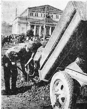
Бетонирование мостовой перед заливкой асфальтом Союзфот
