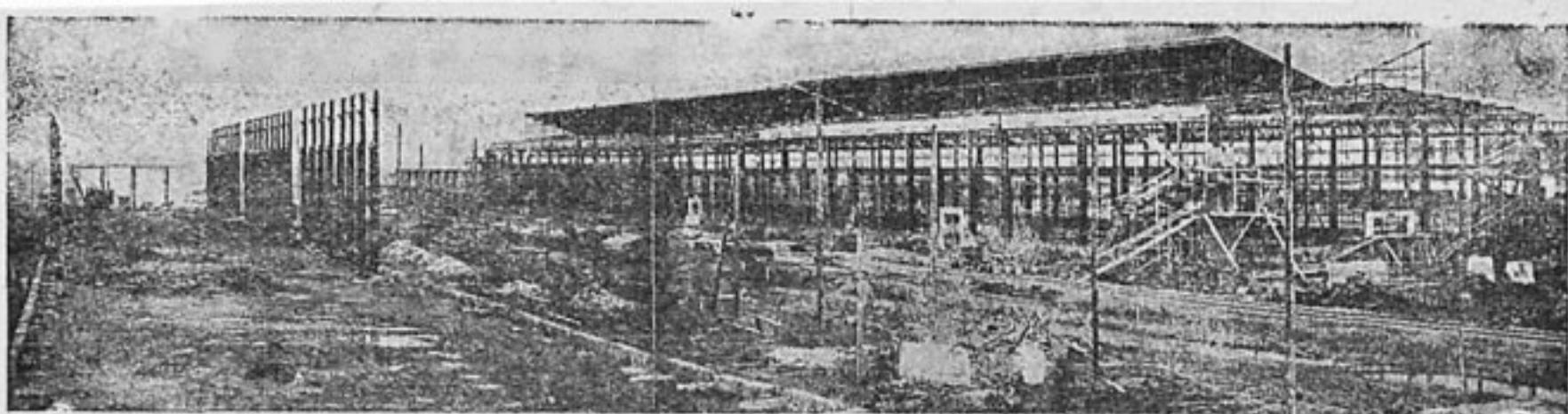
Нижегородский завод. Установка металлических конструкций кузнечного цеха и вид собранного рессорного цеха к концу октября 1930 г. Из фотоархива „За Рулем“
