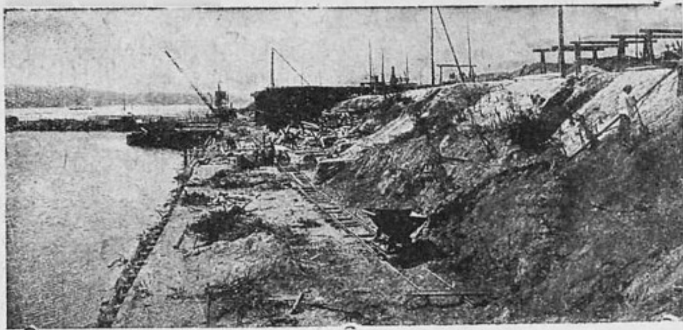
Нижегородский автозавод начат строительством. Порт. Устройство берега и железнодорожной ветки. Июль—август 1930 г. Из фотоархива „За Рулем“
