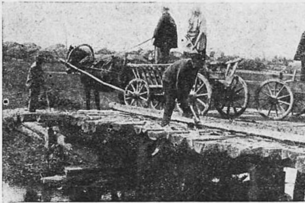
Мост, отремонтированный колхозниками (Копыльский район, сельсовет им. Ланцуцкого)
