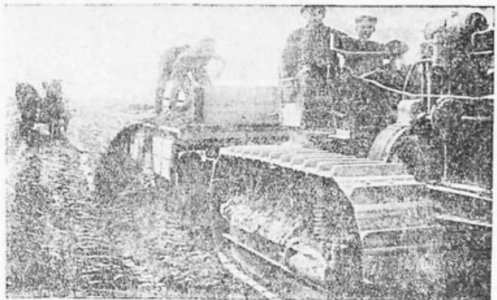
Улучшение грунтовых дорог гравием. Засыпка колеи
