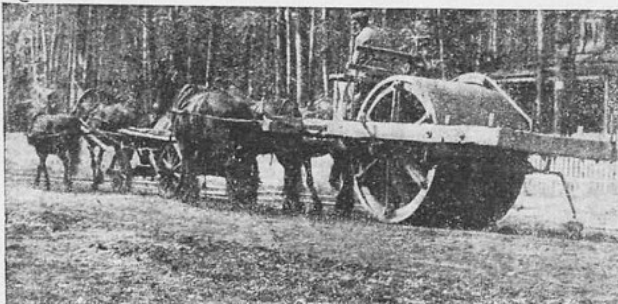
Окончательная укатка отремонтированного шассе конным ратком
