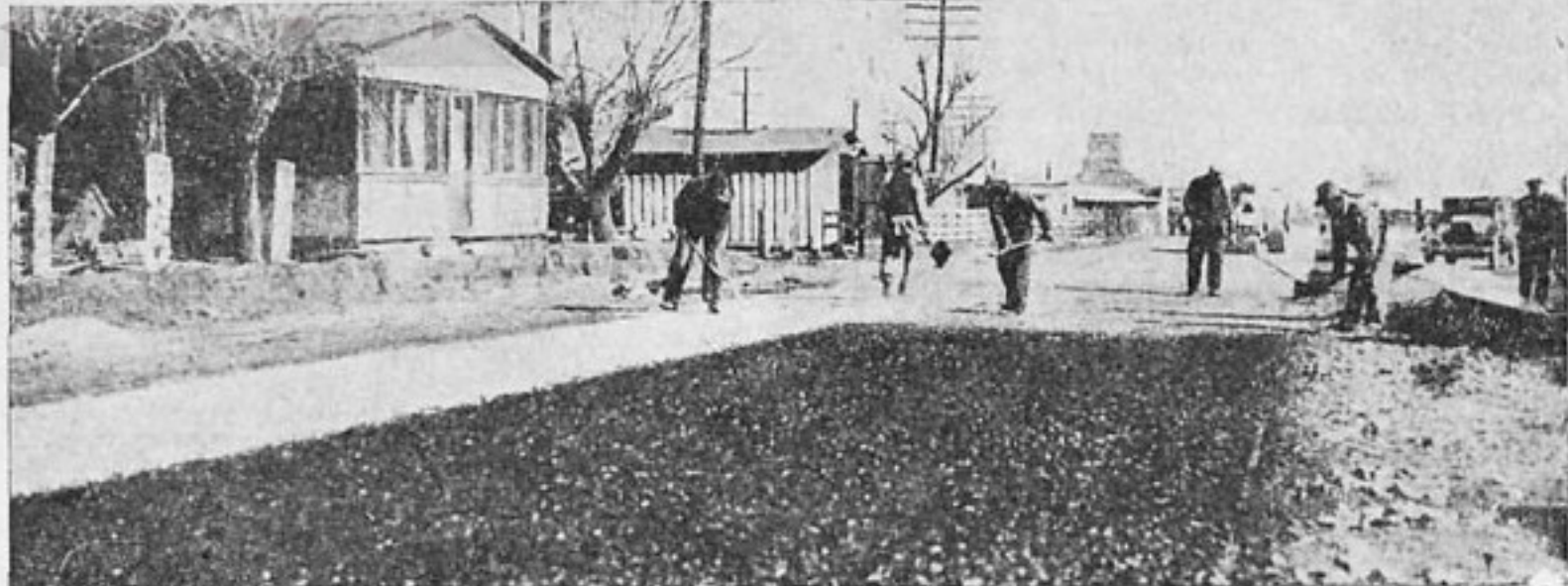
Дорожные работы в Соединенных Штатах. После пропитывания дорогу посыпают мелкими камнями
