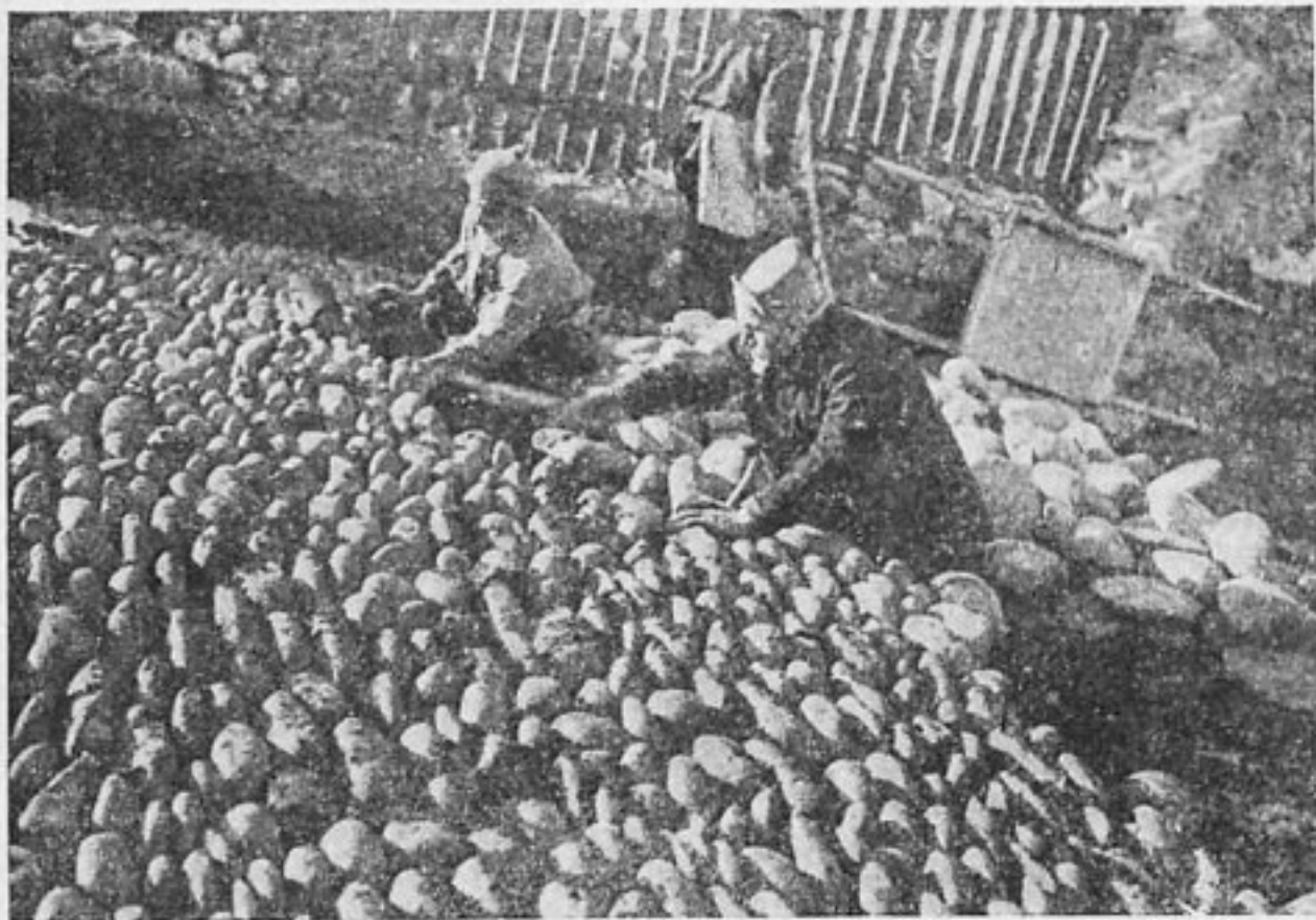
В Таджикистане усиленно разворачивается дорожное строительство.
