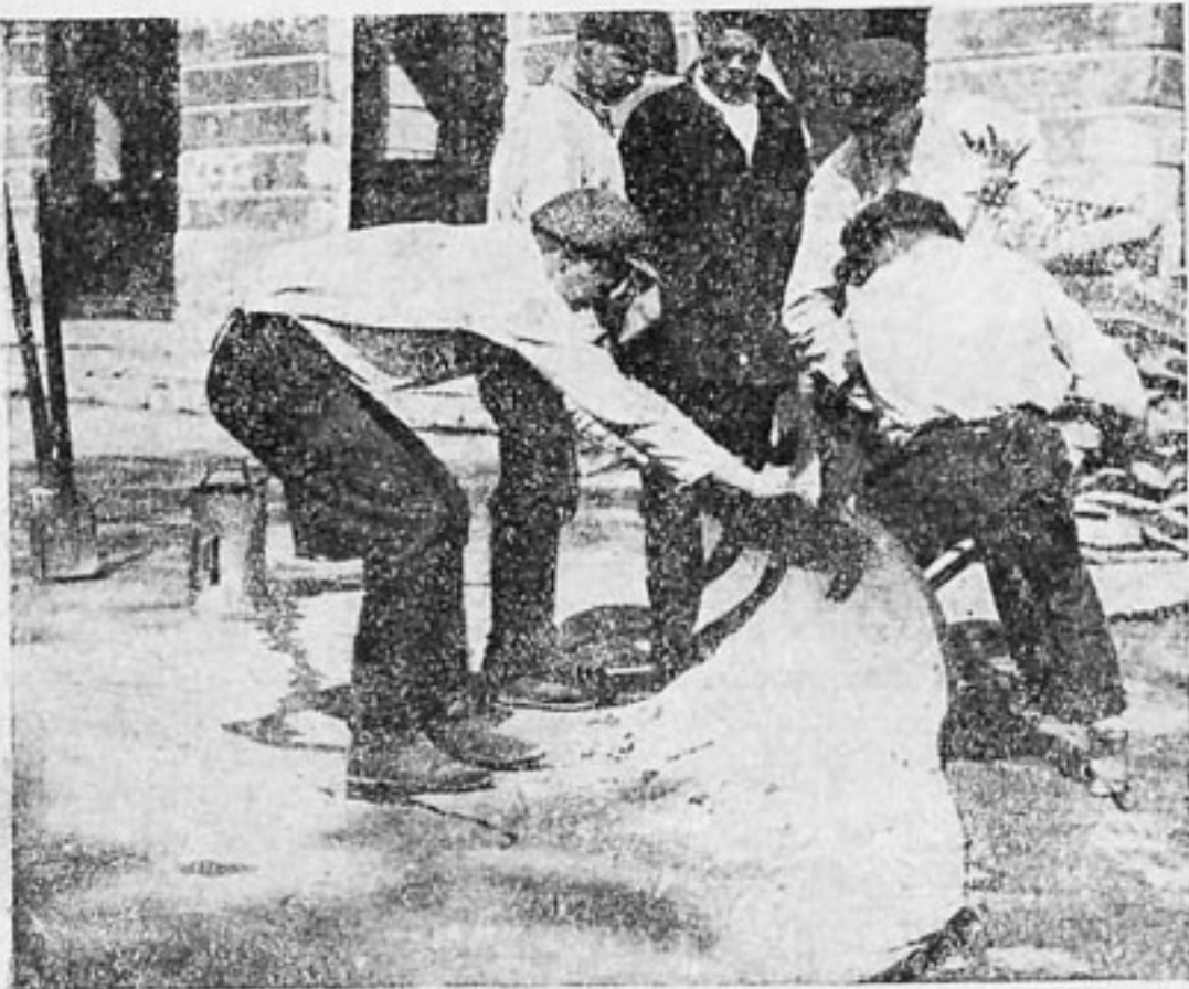
Удаляют плохой асфальт прошлогодней укладки
