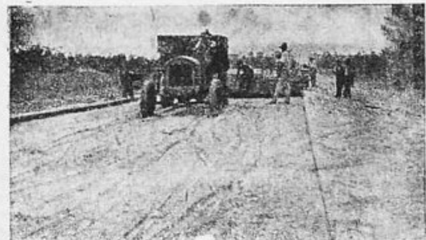
Усовершенствованная одежда из асфальтового раствора (без каменного материала) с применением местного песка. Слева—показан песчаный подстилающий грунт, справа—разгрузка асфальтовой смеси
