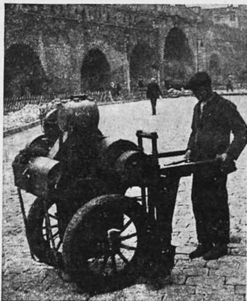
На мостовых работах этого года применяется пневматическая трамбовка
