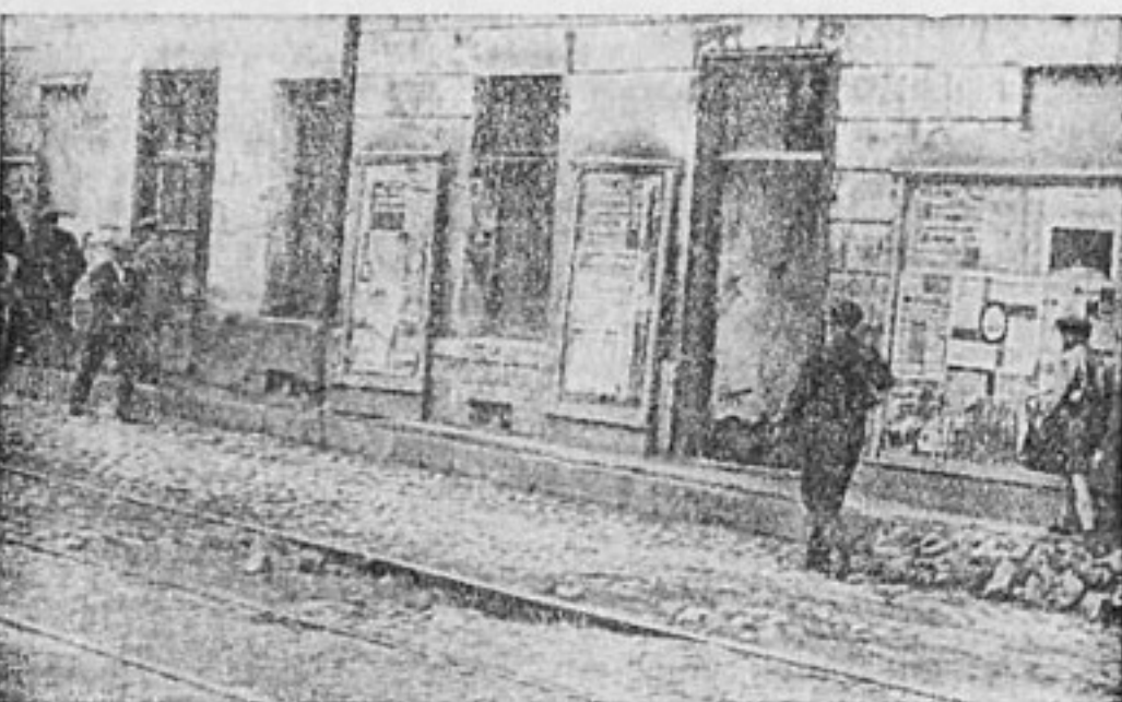
Мостовые нуждаются в усиленном ремонте
