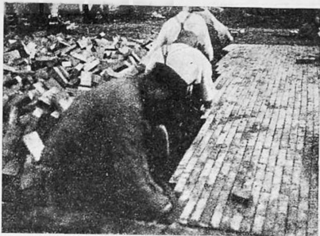
Укладывают клинкер.
