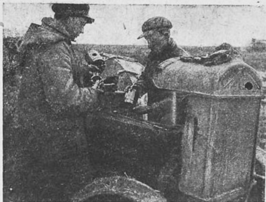
За ремонтом трактора (совхоз Колпино)
