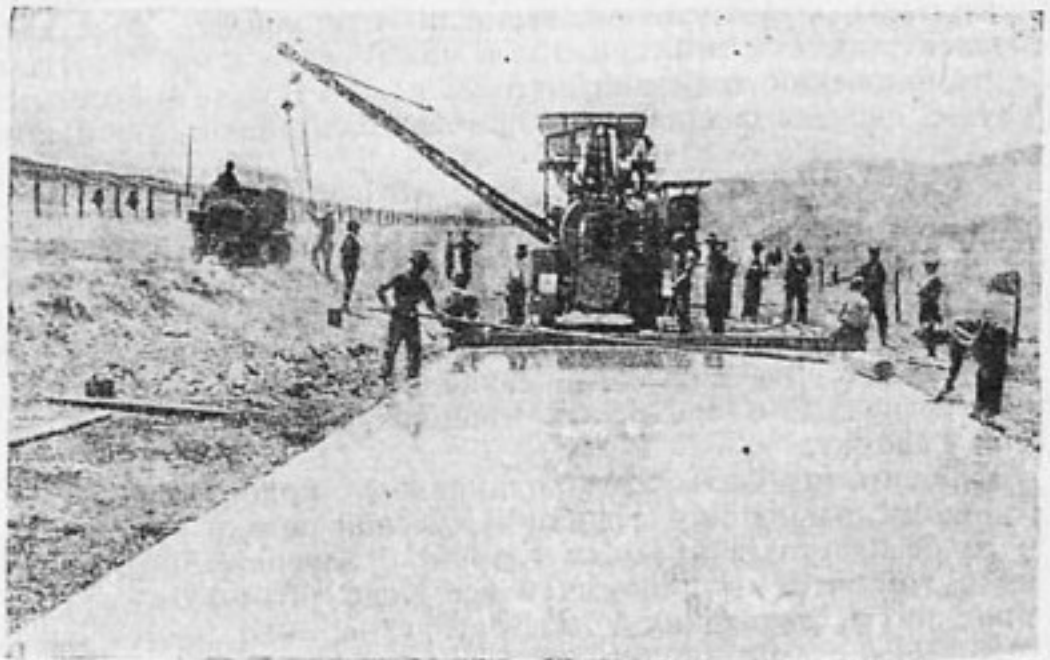
Быстрая механизированная постройка усовершенствованных дорог в САСШ.
