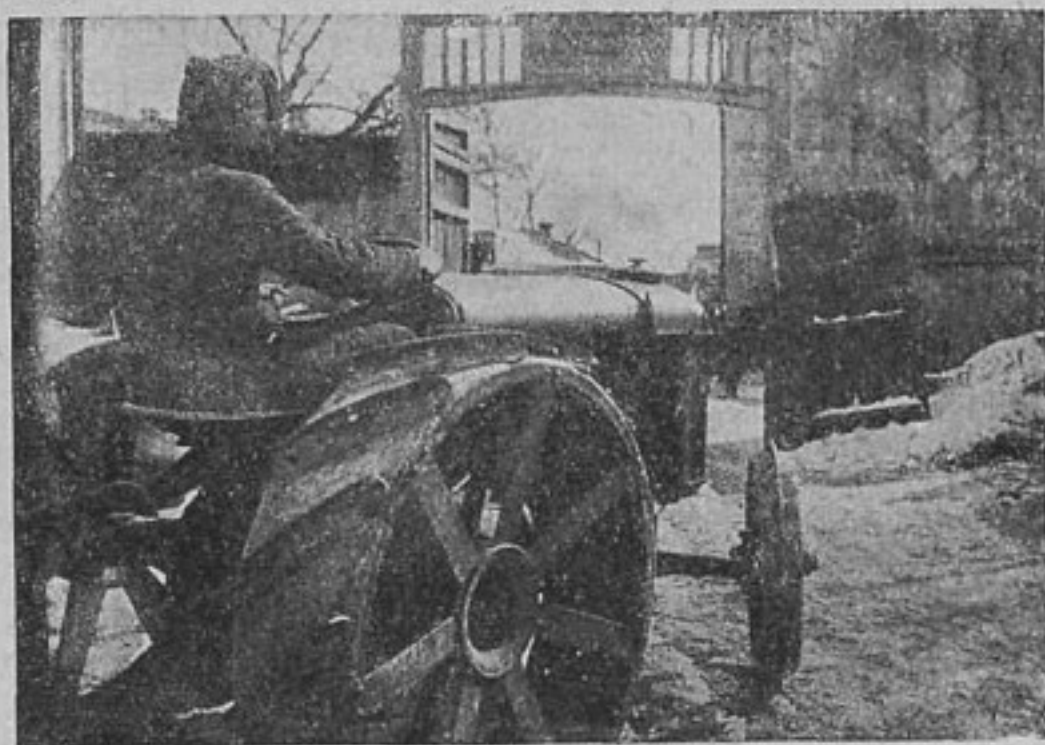
Начинаются зимние работы
