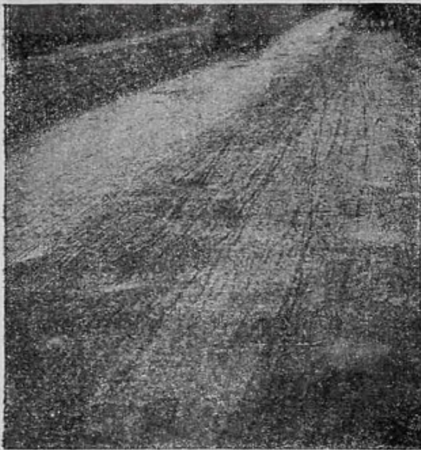
Выстроенная в прошлом году асфальтовая мостовая (1-я Гражданская) сгорбилась и создает при проезде «морскую кашку»
