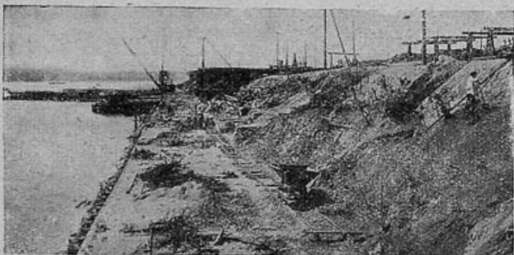
Нижегородский автозавод. Порт. Устройство берега и железнодорожной ветки
