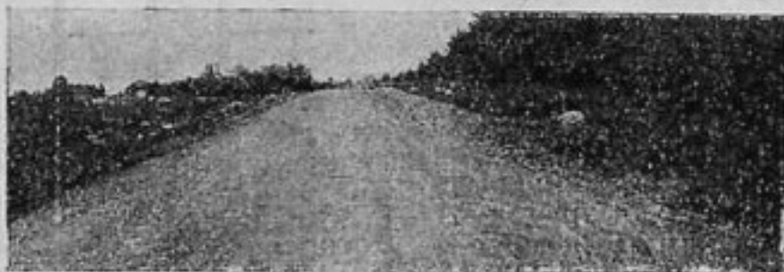
Вид улучшенной грунтовой дороги
