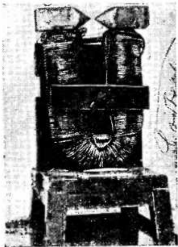
Электромагнит Фарадея. При помощи медного диска, вращающегося между полюсами этого электромагнита, Фарадей впервые осуществил (1831 г.) магнитоэлектрическую машину — обратил магнетизм в электричество.
