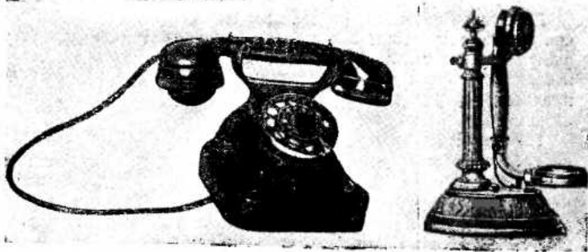
Два телефонных аппарата. Справа: настольный телефон конца прошлого века. Трубка покоится в специальной подставке, которая снабжена нажимной вызывной кнопкой. На левом снимке: универсальный советский аппарат производства завода „Красная зarya“.
