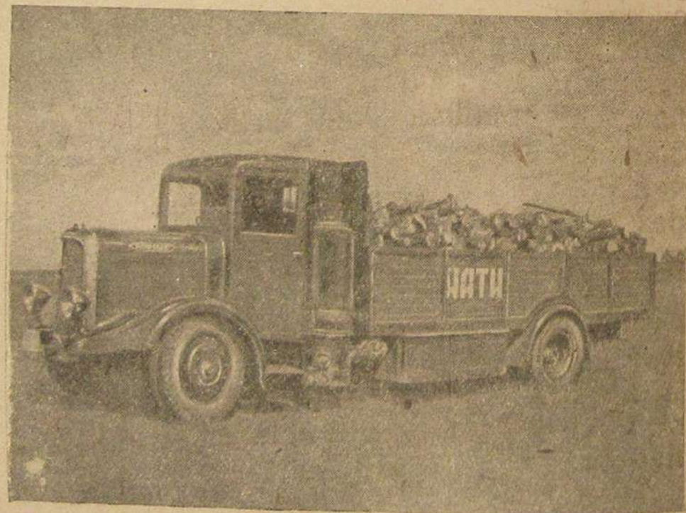
Рис. 5. Автомобиль Панар-Левассор с древесно-угольной установкой Панар.
