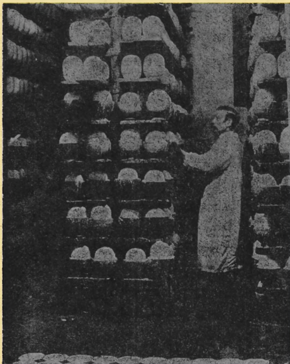
Рис. 29. Подвал-соляильня. Головки сыра посолены соляной гущей (сухая посолка).
