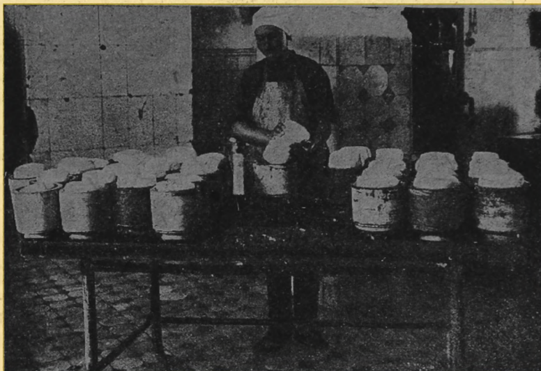
Рис. 22. Переворачивание самопрессующихся кусков сыра.
