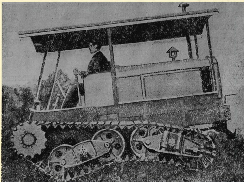
Фиг. 55. Боковой вид гусеничного тягача Гаррет-Гарднер.
